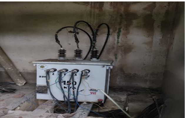
Foto No: 4 Observaciones Particulares: Transformador Biblioteca de 150kVA
